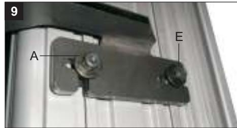
Zur Befestigung Unterlegscheiben "A" und Gewindemuttern "E" benutzen.
